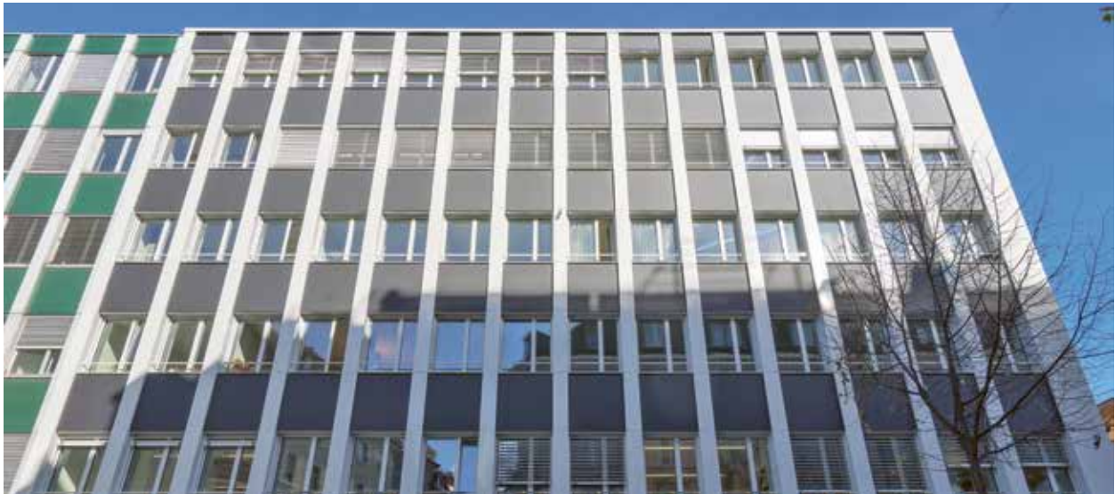
Im Rahmen der Instandsetzung erhielt das Gewerbegebäude aus den 1960er-Jahren eine Solarfassade. Das Erscheinungsbild der Fassade wurde dabei bewusst nicht verändert. Links in Grün ist das unsanierte Nachbargebäude zu sehen.
