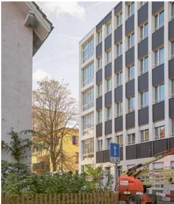
Die beiden Solarfassaden leisten mit einem Ertrag von etwa 8100 kWh pro Jahr einen nicht zu unterschätzenden Beitrag zum Eigenenergiebedarf des Bürogebäudes.
